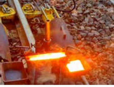
Resim 6.8 Termit tepkimesi – alüminyum ile demir(III) oksit arasındaki tepkime
